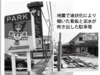
地震で液状化により傾いた看板と泥水が吹き出した駐車場。
